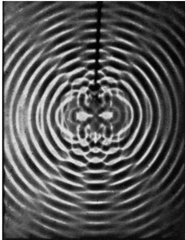
Interferenz zweier kreisförmiger Wasserwellensysteme
